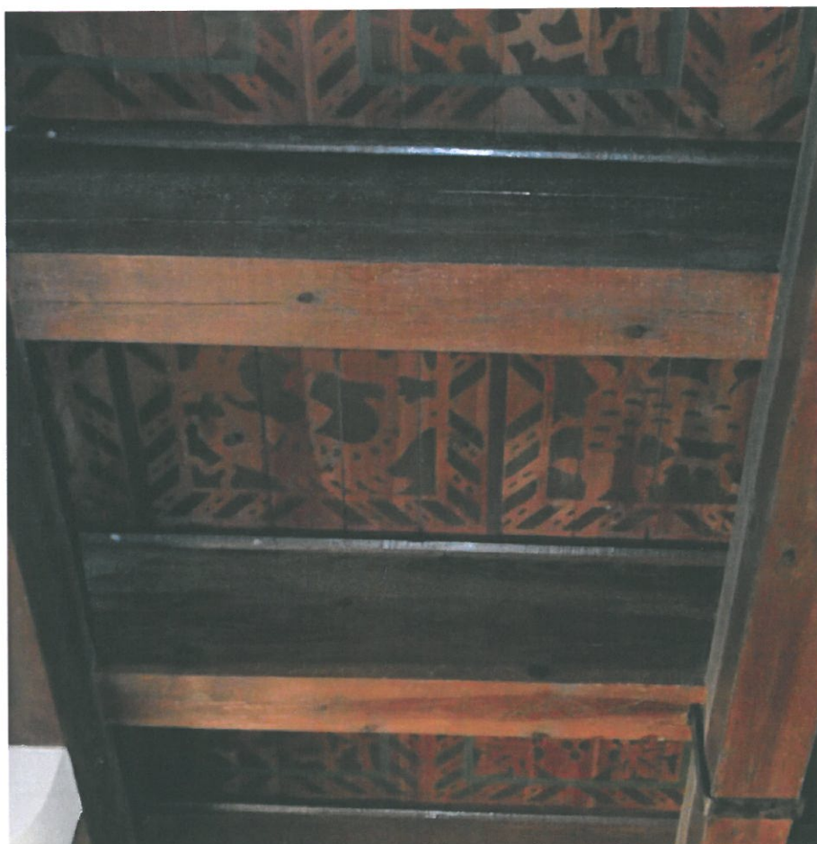
Fot. 7-8. Kościół pw. Podwyższenia Krzyża Świętego w Świeradowie-Zdroju, fragment stropu z lat 30. XX w. z widocznymi otworami wylotowymi owadów szkodników drewna.
