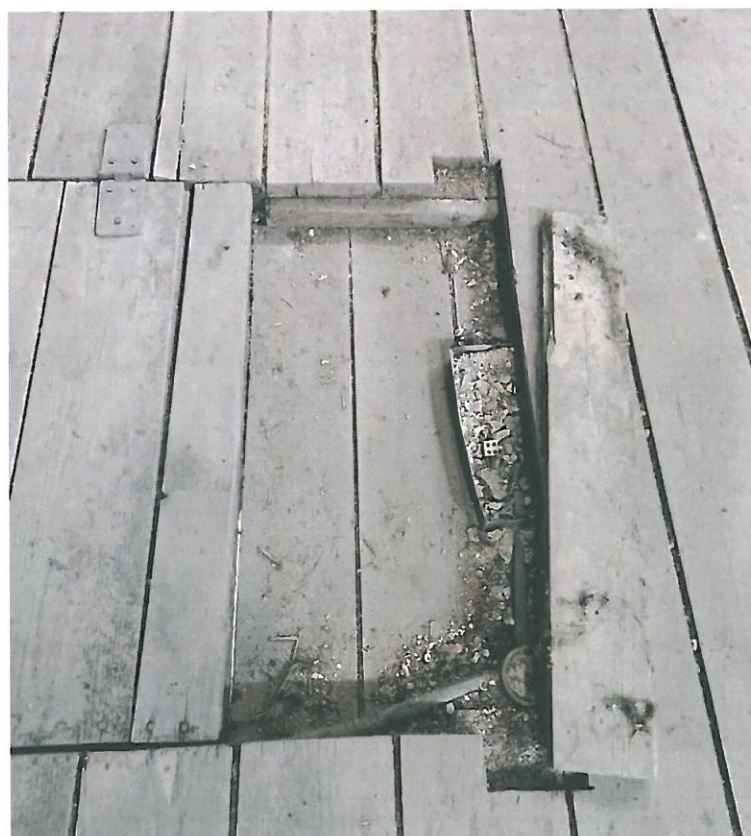
Fot. 12–13. Kościół pw. Podwyższenia Krzyża Świętego w Świeradowie-Zdroju, widoczne otwory wylotowe po żerowaniu drewnojadów na zabytkowych deskach stropu od strony strychu oraz zalegający na nich brud i kurz.
