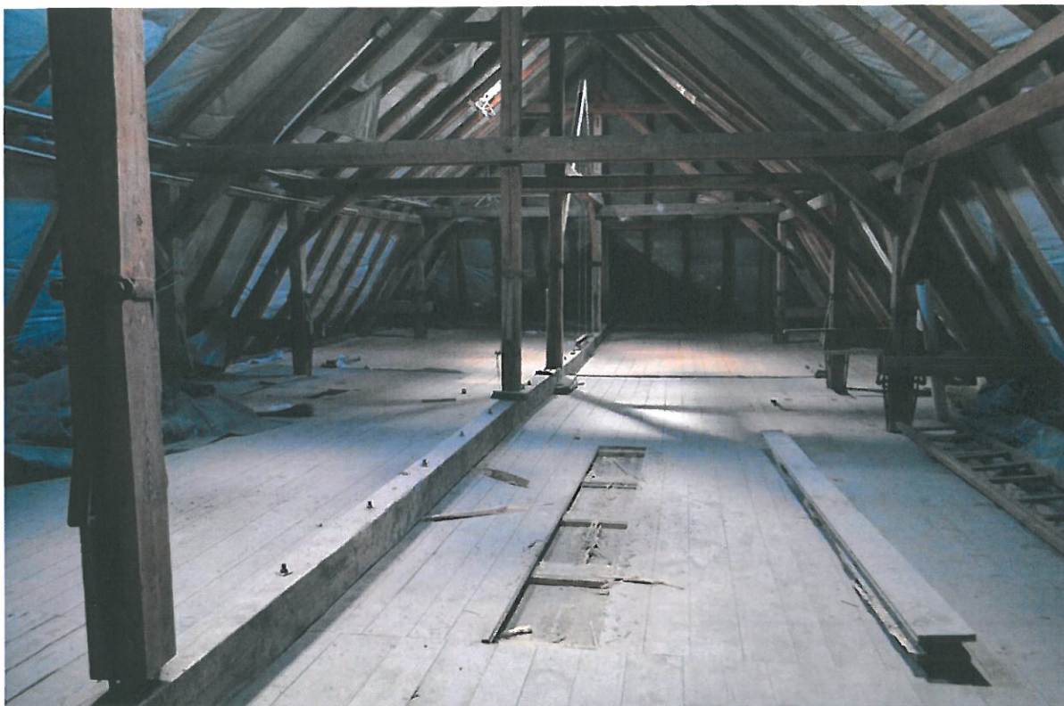
Fot. 9. Kościół pw. Podwyższenia Krzyża Świętego w Świeradowie-Zdroju, widok strychu z wymienioną nową podłogą w części zachodniej; w części wschodniej zdjęte częściowo zdestruowane deski podłogi odsłaniające zabytkowy strop.
