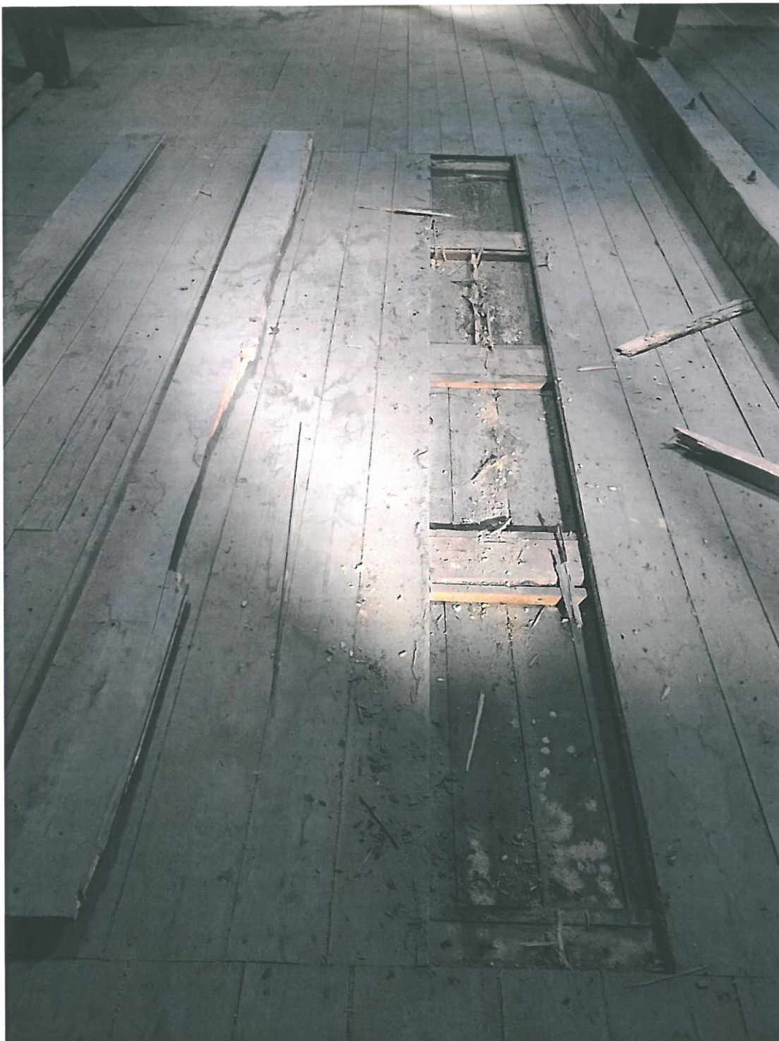
Fot. 11. Kościół pw. Podwyższenia Krzyża Świętego w Świeradowie-Zdroju, widoczne uszkodzenia starych desek podłogi na strychu spowodowane żerowaniem drewnojadów oraz wysypująca się z otworów wylotowych jasnożółta mączka drzewna z owadziemi odchodami.
