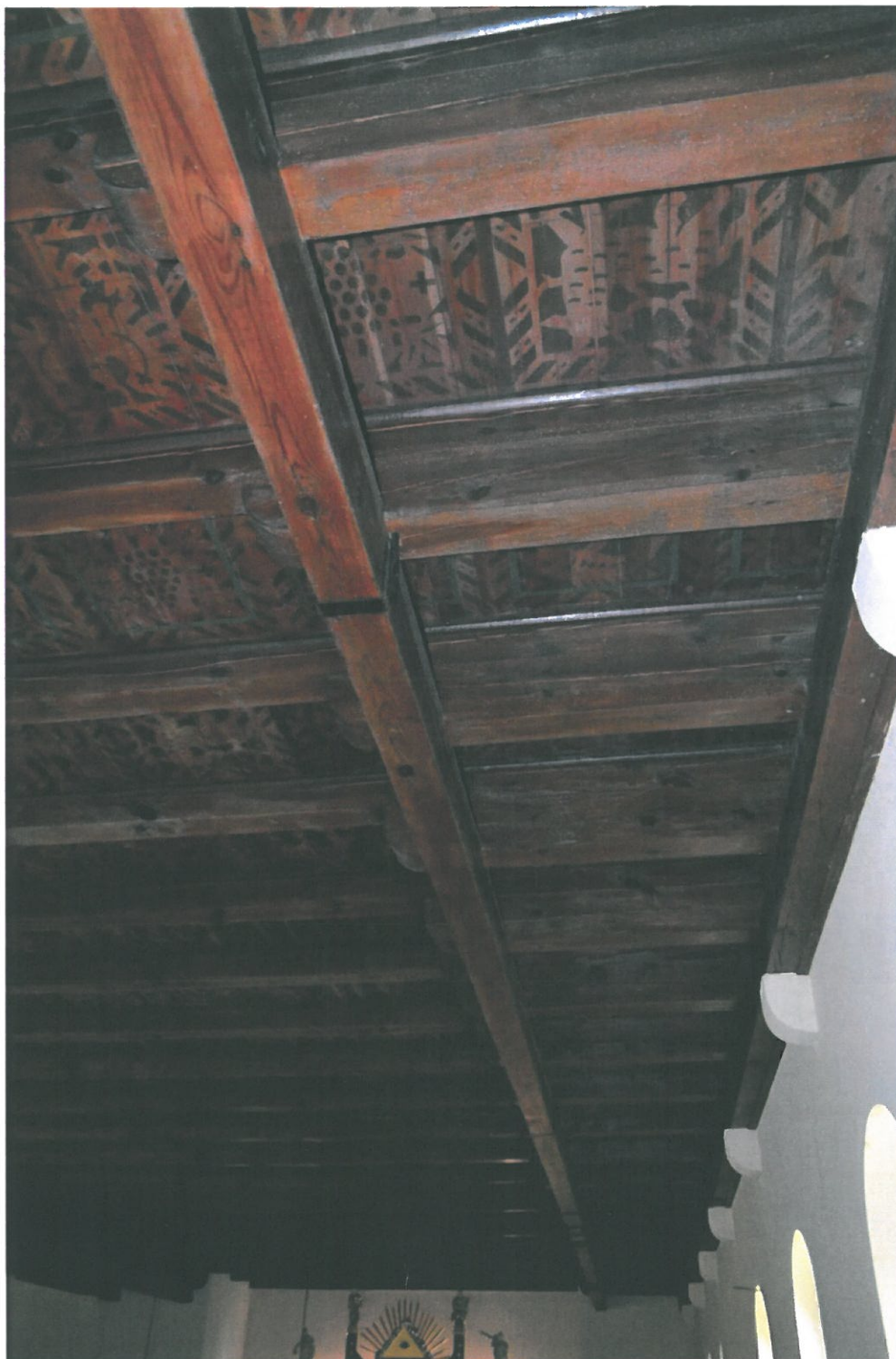
Fot. 6. Kościół pw. Podwyższenia Krzyża Świętego w Świeradowie-Zdroju, fragment stropu z lat 30. XX w. z widocznymi otworami wylotowymi owadzich szkodników drewna.
